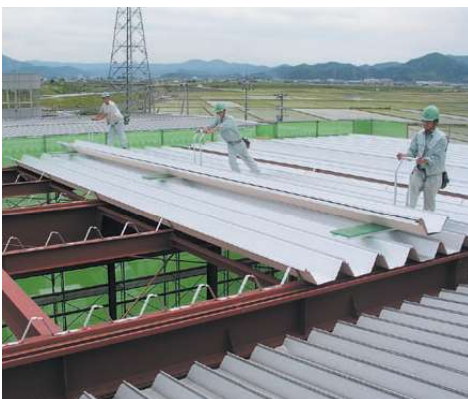
▲折板の仮葺移動
